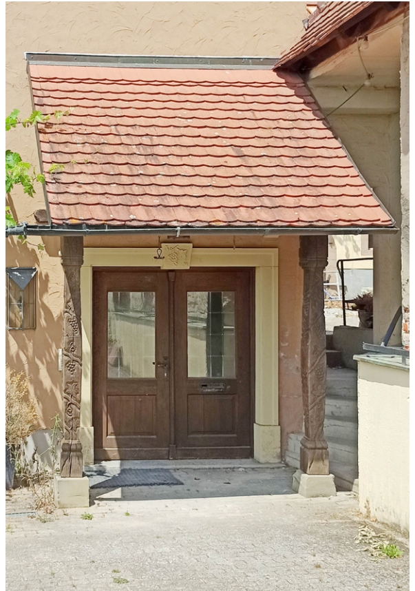
Holzkonstruktion mit Ziegeleindeckung
