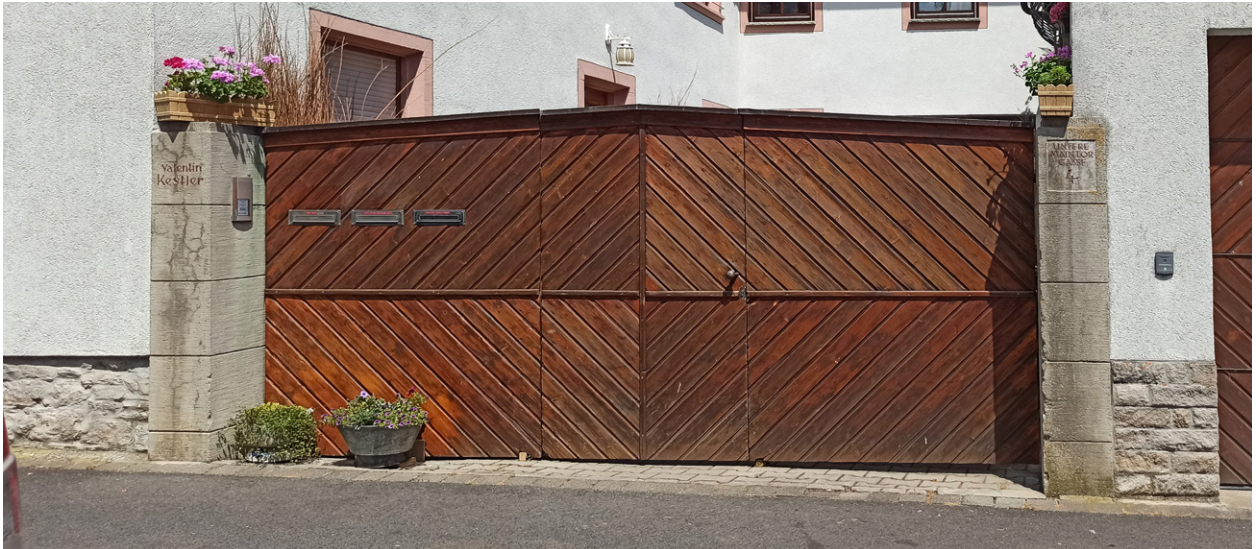
Hoftor aus Holz mit integrierter Pforte und Torpfeilern
