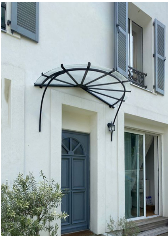
Stahlkonstruktion mit Glasdach 5
