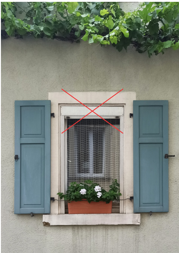
Sichtbarer Rollokasten; Laden mit Kassetten
