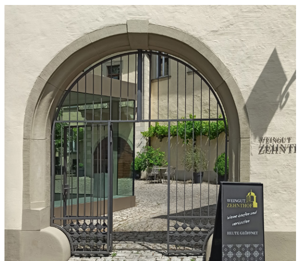
Rundbogentor mit integrierter Pforte
