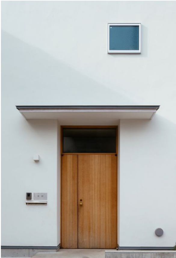
Kragdach aus Beton 4
