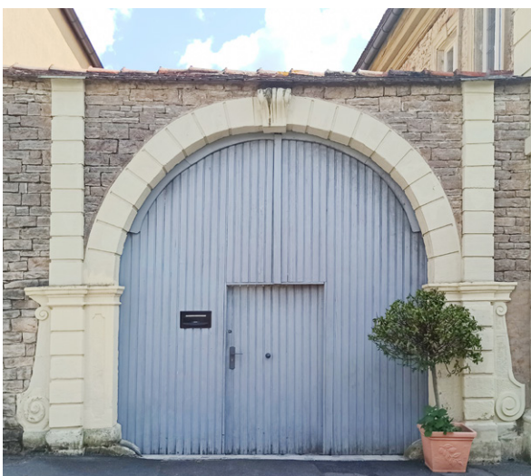
Rundbogentor mit integrierter Pforte
