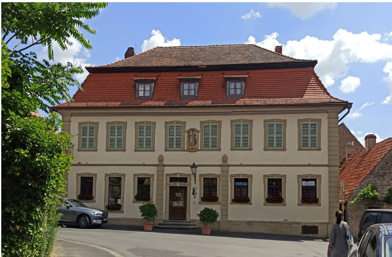
Mansardwalmdach mit Schleppgauben, regelmäßige Fensterachsen
