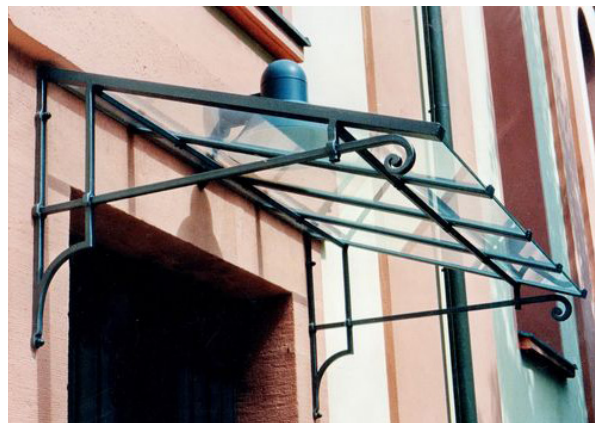
Stahlkonstruktion mit Glasdach 6
