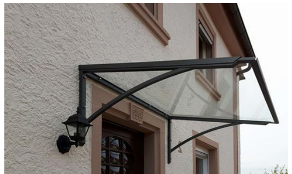
Stahlkonstruktion mit Glasdach 7
