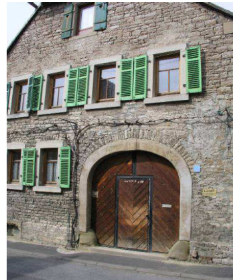
Abbildung 31: Traditionell gestaltete Hoftoranlage Häckergasse 8, kein Denkmal
