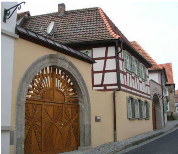
Abbildung 42: Neubau einer Toranlage in Anlehnung an historische Formen, Hauptstraße 16
