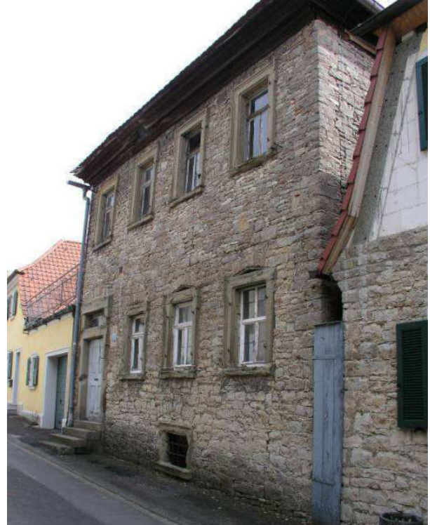
Abbildung 45: Wohngebäude Häckergasse 11, leer stehend
