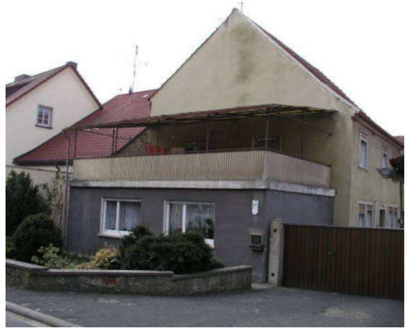
Abbildung 56: Gestalterische Defizite in der Järgasse
