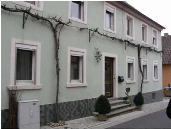
Abbildung 40: Häufige Überformungen wie hier am Bsp. Anwesen Turmstraße 1 mit Klinkerverkleidung am Sockel, Rollläden und neuer Haustüre
