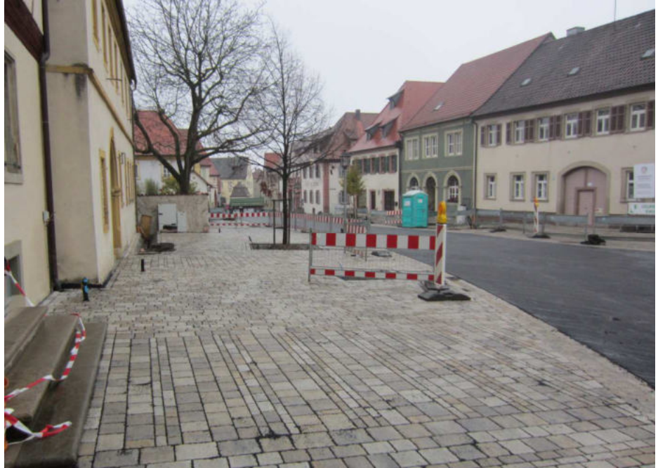
Abbildung 71: Abschluss der Bauarbeiten in der Hauptstraße, Winter 2013
