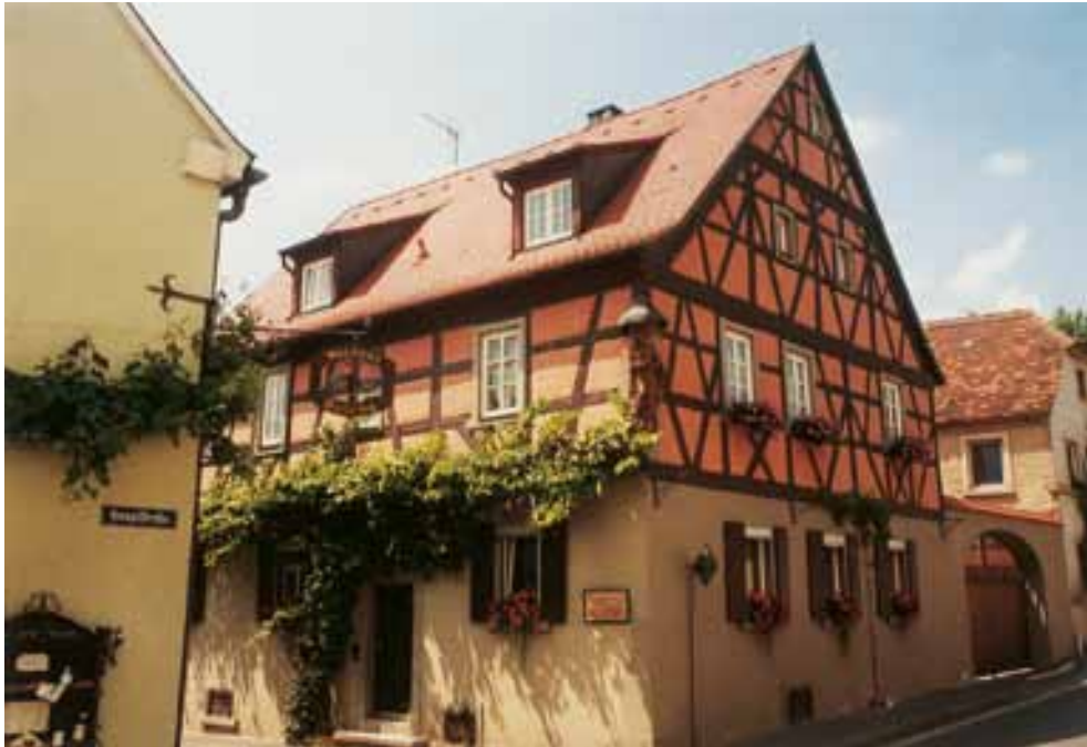
Wohnhaus mit einfachem, konstruktivem Fachwerk im Obergeschoss (OG), das gemauerte Erdgeschoss (EG) ist verputzt.
