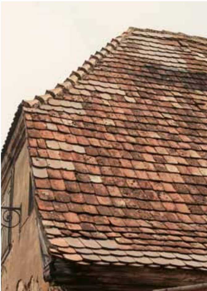
Traditionelle Dachkonstruktion mit Aufschiebling, sehr schmalem Dachüberstand an Ortgang und Traufe; Eindeckung mit Bieberschwanzziegeln, hier noch handgestrichene Ziegel.
