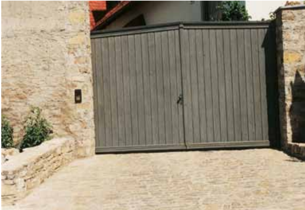
Modernes Tor an Hofeinfahrt in schlichter Formensprache: vertikal angeordnete Holzbretter, gelungene, unaufdringliche Farbgebung, passend zu den umgebenden Flächen und Mauern aus Kalkstein.
