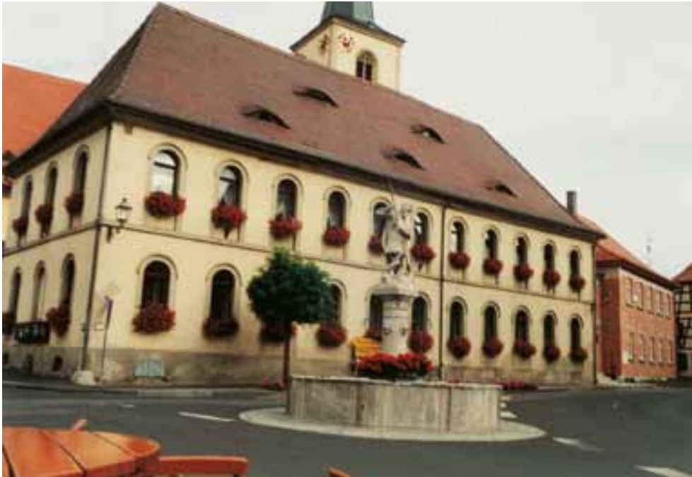
Voluminöses Dach mit Vollwalm, wie in Sommerach häufig, ruhige Dachfläche mit schmalen Fledermausgauben (nur zur Belüftung), profiliertes Traufgesims.
