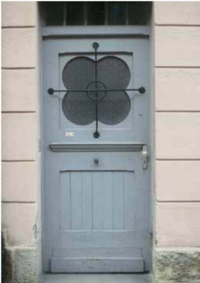
Moderne Haustür in traditioneller Gestaltung; wenige Materialien verwendet: Massivholz, Glas, Schmiedeeisen; Belichtung durch Glasfeld im oberen Türfeld und durch Oberlicht.
