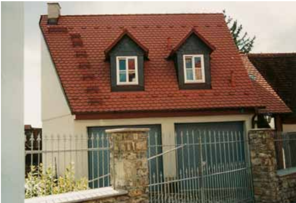
Schlichte Satteldachgauben auf Neubau mit seitlicher Schieferverkleidung; konstruktiv geteilte Fenster; der Kamin tritt erst am First aus der Dachhaut hervor.
