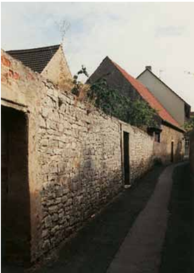
Charakteristische Abgrenzung eines Grundstücks durch hohe Kalksteinmauer, hier sogar beidseits eines Fußweges; an den Zugängen Sandstein verwendet; Nebengebäude werden häufig an die Mauer angebaut.
