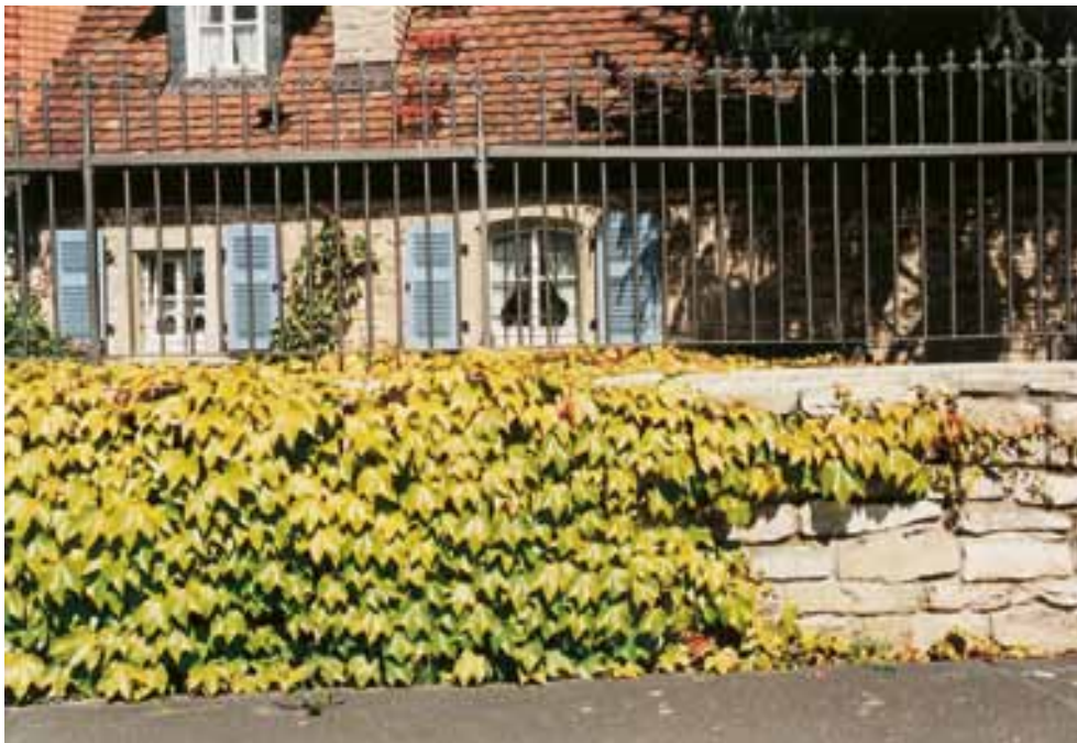
Harmonisch gestaltete neue Einfriedung am Rande des Altortes: Mauersockel aus Kalkstein, mit Wilden Wein bewachsen; darüber ein einfacher Eisenzaun mit senkrechten Stäben und verzierten Spitzen.
