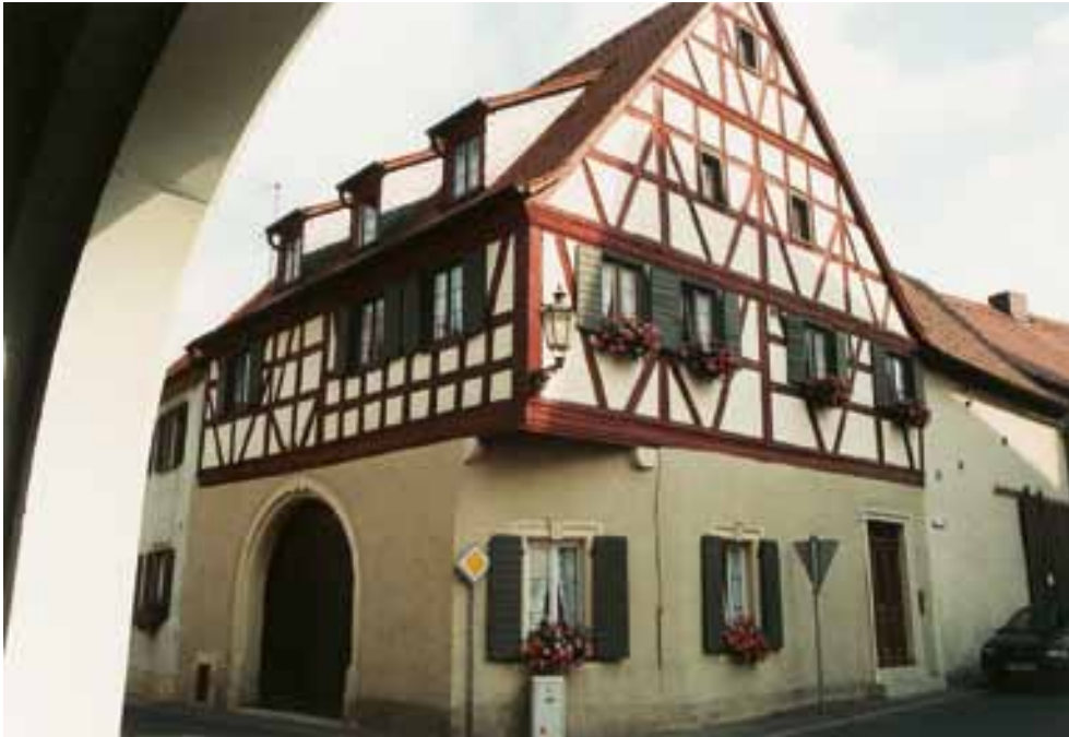
Neue, gut eingefügte Schleppegauben an histor. Gebäude für nachträglichen Dachausbau; dadurch konnten die historischen kleinen Giebelfenster im Dach erhalten werden.
